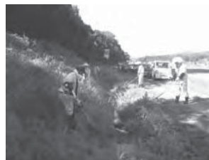
水路の草刈作業
