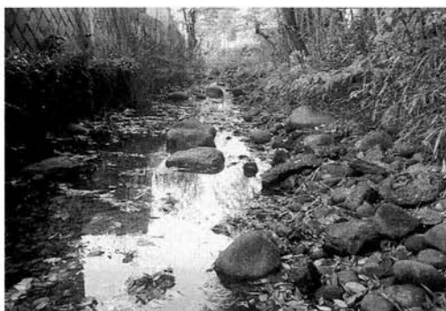
写真3. 改修前 水を止めた善光寺用水
